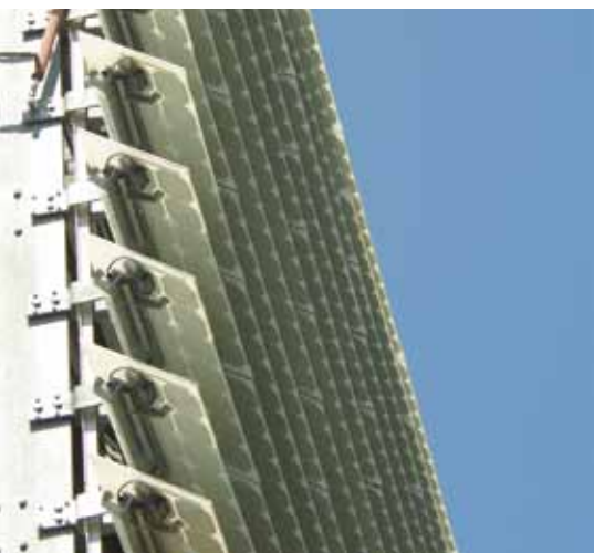
太阳能发电站， 用 ergo. ® 结构胶粘接电池片和机械架构
